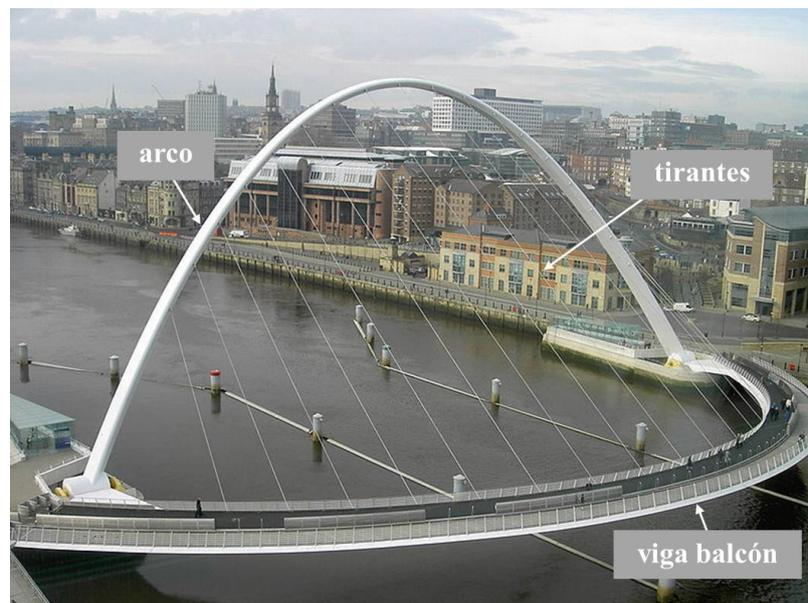
*Fig. 3.9: Elementos estructurales: arco, tirantes y viga balcon*
