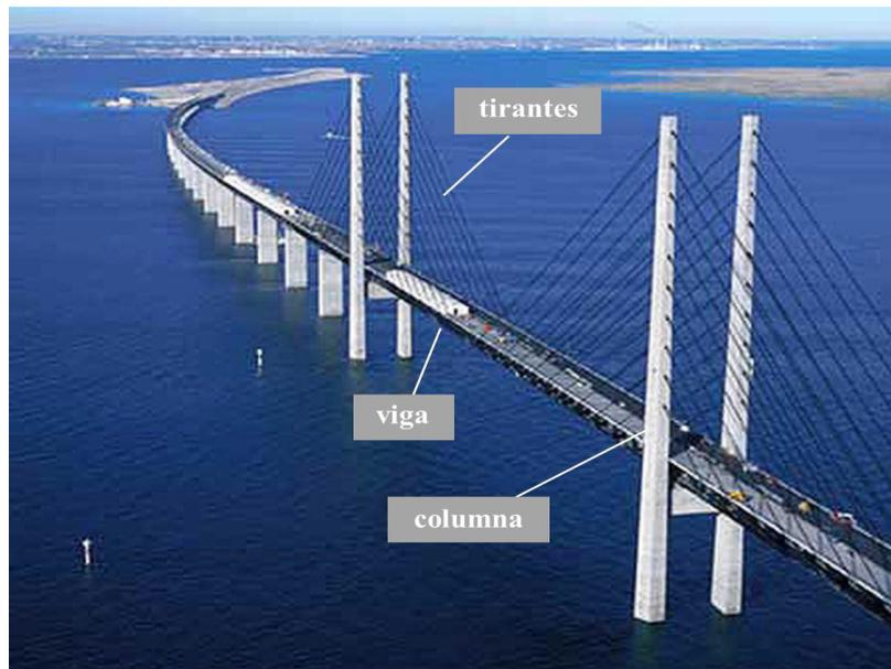
*Fig. 3.8: Elementos estructurales: vigas, columnas y tirantes*
